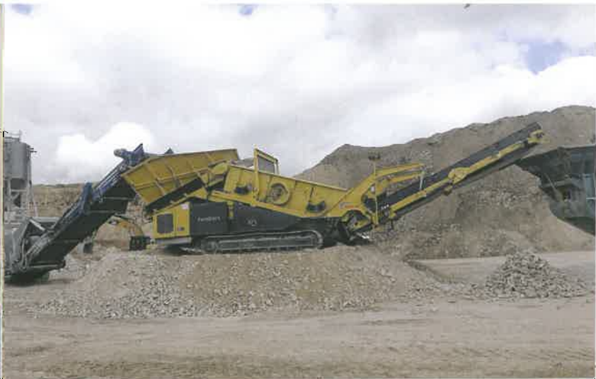
Les groupes mobiles n'ont pas la même hauteur ce qui implique de réaliser des plateformes pour qu'ils soient au même niveau, surtout pour le scalpeur Keestrack K6 qui jette ses matériaux dans la trémie du concasseur XH500SR.
